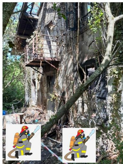
Attaque depuis une fenêtre et la porte d'entrée façade A, chaque SP disposant d'une lance
